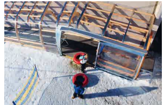
Sowohl der Einstiegsbereich, als auch der Ausstiegsbereich sind zur Gänze überdacht.
